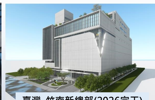
臺灣_竹南新總部(2026完工)
